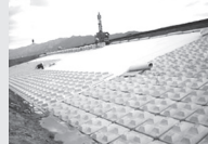
遮水マット施工イメージ写真
