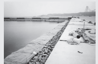
“NK-500S”施工イメージ
