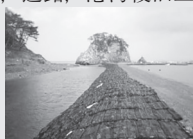
当時の施工現場風景 “ジオシェルトン”
