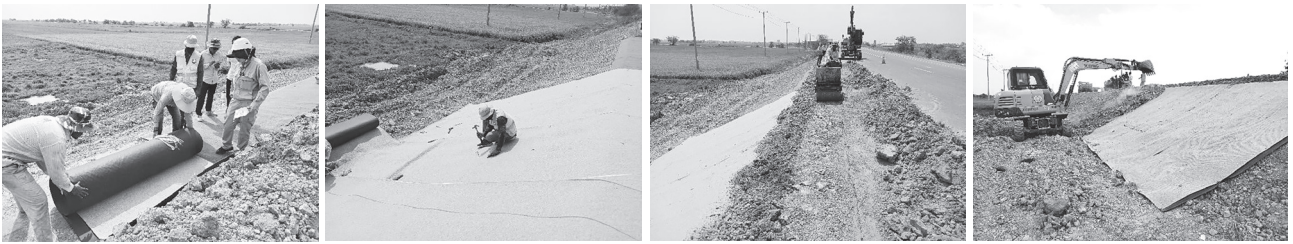
写真5 カンボジアでのジオストリーム敷設作業の様子
