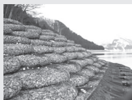
当時の施工現場風景 "JY-1T"
