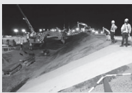
当時の施工現場風景 “WSP-10R”
