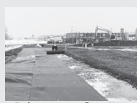
“プロテックス”の施工イメージ
