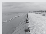
“ニードキーパーNK-500S”の施工イメージ
