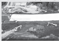
当時の施工現場風景 “WSP-10R”
